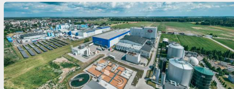
Fabryka mleka UHT (Mlekovita) w Wysokiem Mazowieckiem 12 607 m 2 powierzchni, 206 579 m 3 kubatury, 18,74 m wysokość budynku
