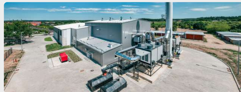
Kotłownia biomasy w Orzyszu 2 529 m 2 powierzchni, 14 276 m 3 kubatury, 538 m 2 pow. składowania biomasy
