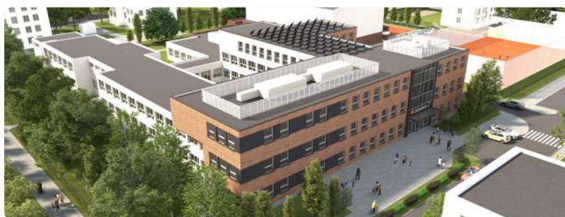
Szkoła Podstawowa nr 3 w Pruszkowie 50 modułów, 3 kondygnacje, ok. 2 600 m 2 powierzchni użytkowej
