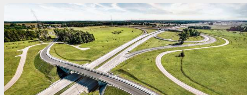
Projekt i budowa drogi ekspresowej S61 Odcinek: Szczuczyn – Węzeł Ełk Południe
