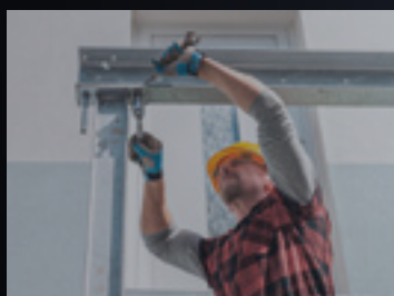
// Konstrukcje stalowe, budowa hal
