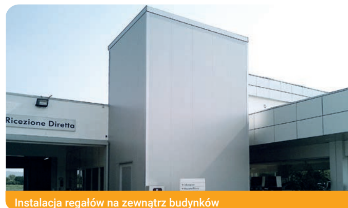
Instalacja regałów na zewnątrz budynków
