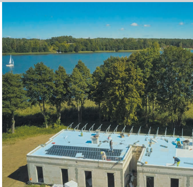
Dach przed hydroizolacją
