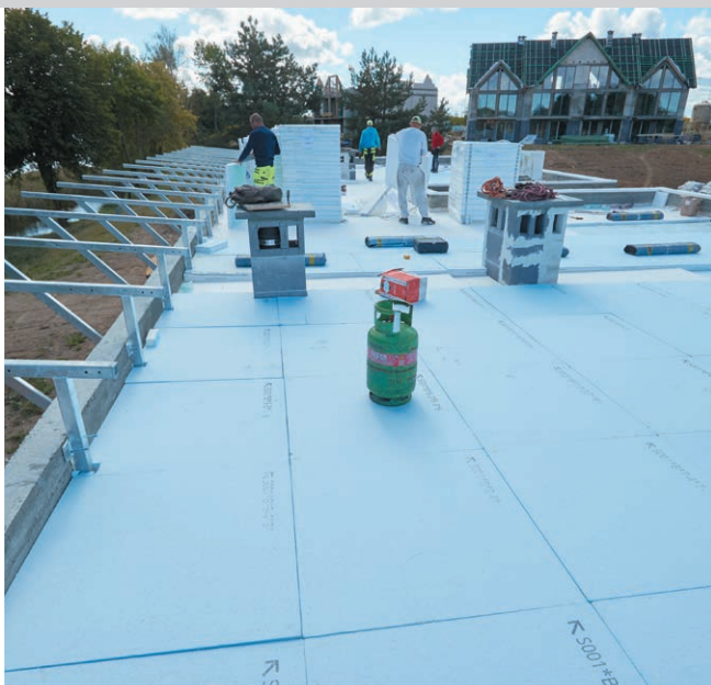
Instalacja spadków eliptycznych
