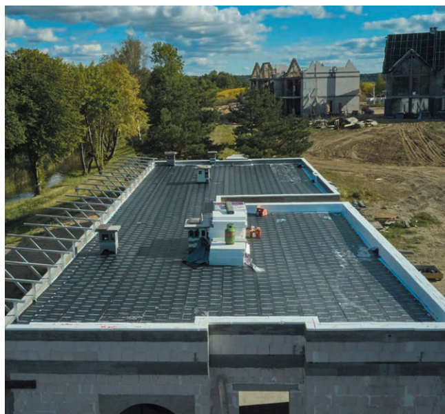
Dach przed hydroizolacją
