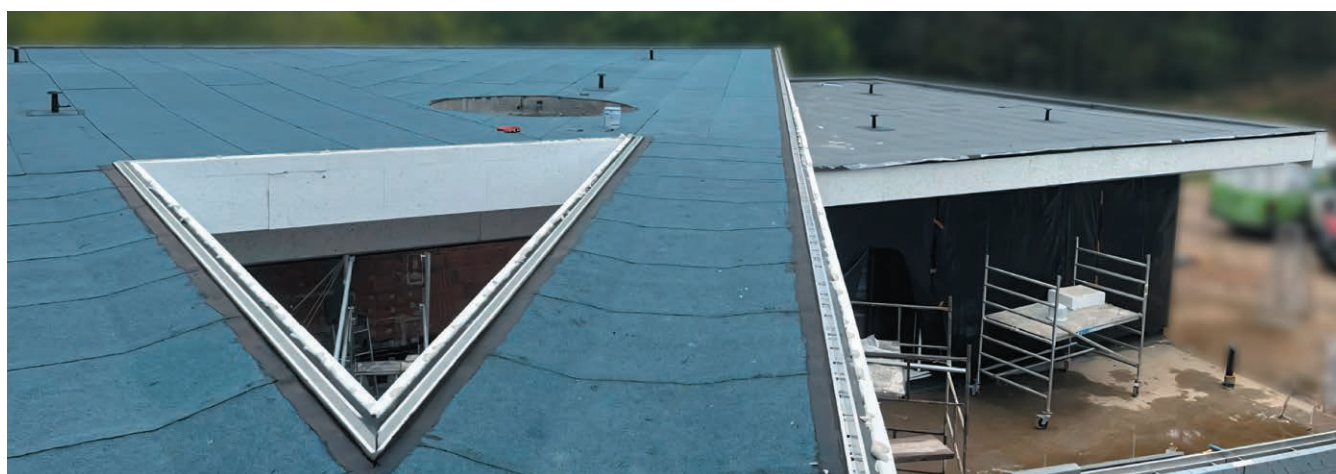
FOT. 2 Gotowy dach
