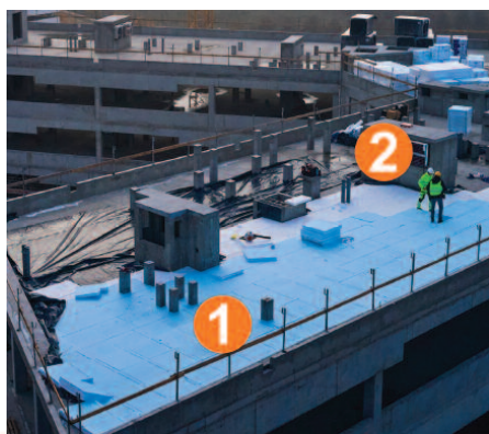
▲ Projekt odwodnienia i spadków eliptycznych, zoptymalizowany pod kątem skutecznego odprowadzenia wody oraz ilości zastosowanego materiału płyt spadkowych – Al
