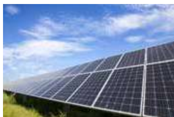
Instalacje wytwarzania OZE w różnych obiektach
