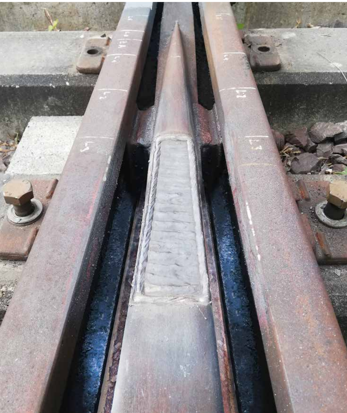
Naprawa rozjazdu przy użyciu HARDFACE AP-O.
