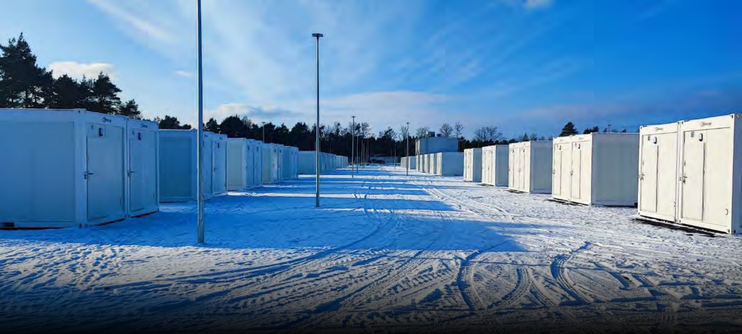
Obiekty mieszkalne, przykład realizacji – Żagań, zaplecze wojskowe dla Akademii Wojsk Lądowych z Wrocławia. 189 systemów kontenerowych
