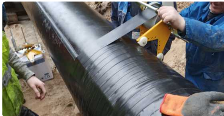
Aplikacja taśm ochrony przeciwkorozyjnej na rurociągach
