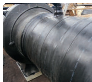
Izolacja połączeń spawanych na zaworze DN 1000
