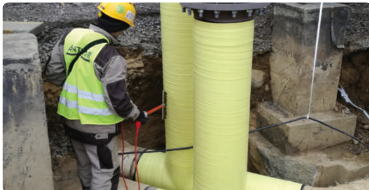
Badanie szczelności powłoki izolacyjnej
