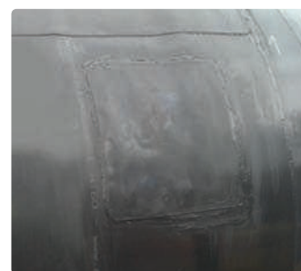
Naprawa uszkodzenia zestawem naprawczym ANTICORRay® REP
