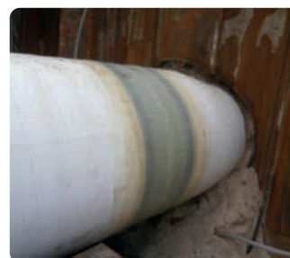
Rękaw ANTICORRay® WSS60 wzmacniany laminatem
