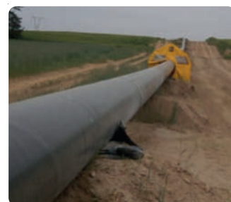
Rurociąg liniowy DN 700 izolowany rękawem ANTICORRay® WSS60
