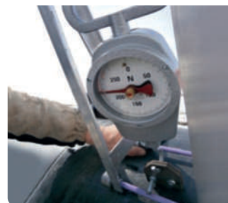
Test przyczepności rękawa ANTICORRay® WSS60
