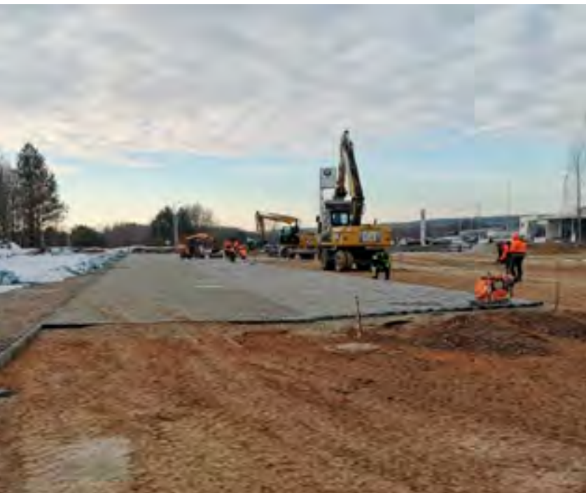
—Pod koniec roku ruszyły prace związane z budową nowego parkingu oraz niezbędnej infrastruktury przy ulicy Wystawowej.
