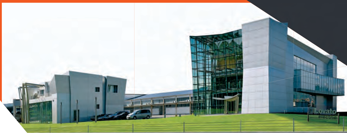
Siedziba LOVATO Electric - Bergamo (WŁOCHY)
