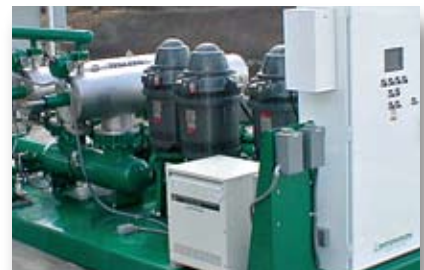
Pionowa stacja pomp
