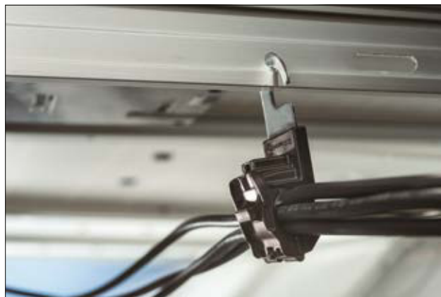
Obejma Ratchet P-Clamp zamocowana do panelu fotowoltaicznego.
