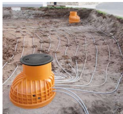
Układanie kolektorów geotermalnych RAUGEO
