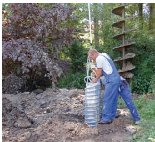
Montaż sondy RAUGEO Helix PE-Xa
