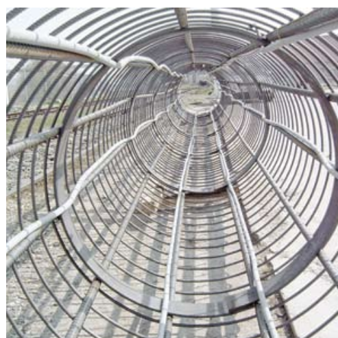
Kolumna geotermalna przed montażem
