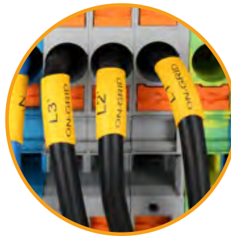
SPECJALNE OZNACZENIA PRZEWODÓW ROZDZIELNIC SZR
