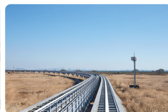
Kontrola infrastruktury kolejowej
