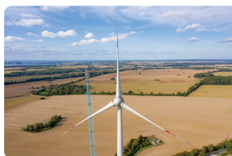
Kontrola instalacji elektroenergetycznych
