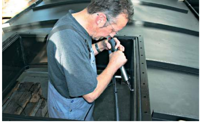
Spawanie przy pomocy Leister DIODE PID
