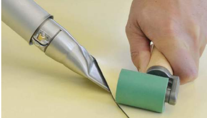
Zgrzewanie na zakładkę folii hydroizolacyjnej
