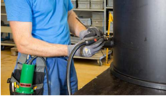
LABOR S z dmuchawą MINOR: spawanie przepustu
