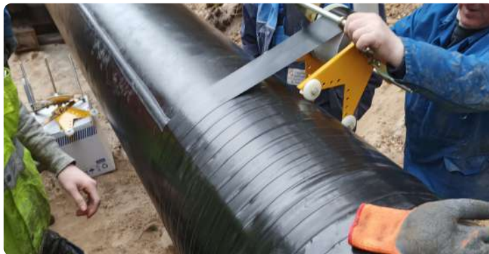
Aplikacja taśm ochrony przeciwkorozyjnej na rurociągach
