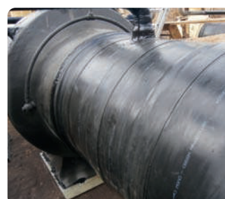
Izolacja połączeń spawanych na zaworze DN 1000
