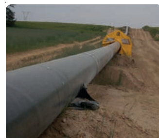
Rurociąg liniowy DN 700 izolowany rękawem ANTICORRay® WSS60
