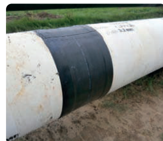
Izolacja połączenia spawanego na rurze z izolacją 3LPP
