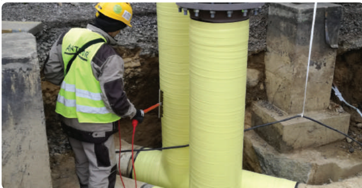
Badanie szczelności powłoki izolacyjnej
