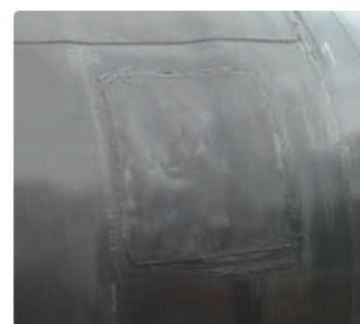
Naprawa uszkodzenia zestawem naprawczym ANTICORRay® REP
