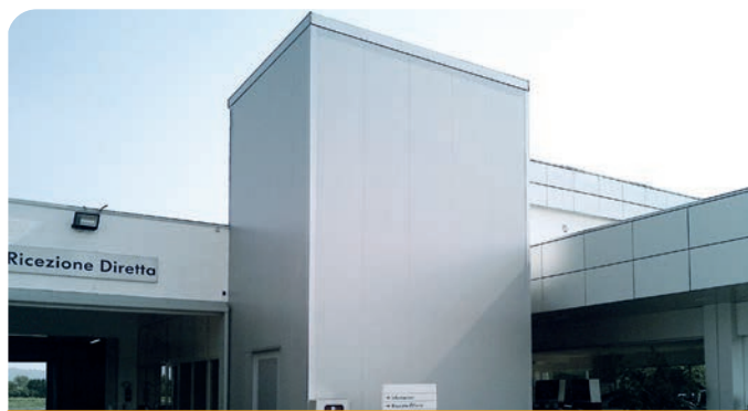
Instalacja regałów na zewnątrz budynków
