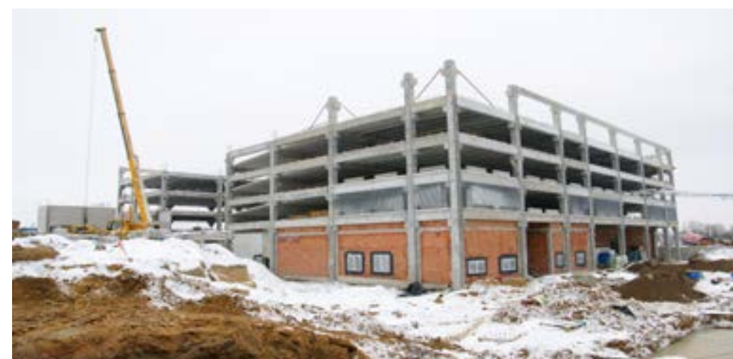
Budowa parkingu wielopoziomowego Multi-storey car-park under construction
